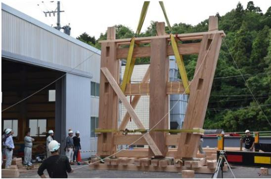
写真3 事前に工場ではフレームを組み、吊り上げている様子
