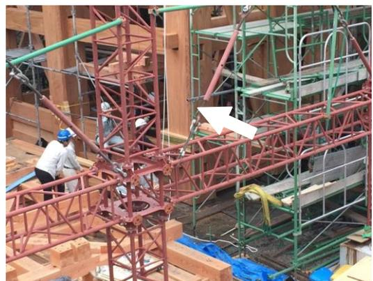
写真2 ④通り基本フレームを所定の位置に引き付けているところ
